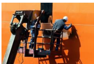
Sécurité des Chantiers Travaux en Hauteur
